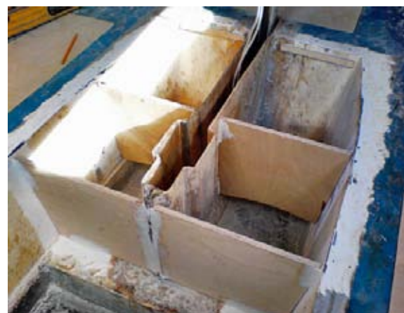
Установка дополнительных усилений швертового колодца. Впоследствии колодец со швертом внутри будет продолжен до потолка рубки и будет выполнять функцию и пиллерса. Шверт будет подниматься на тросе по специальному металлическим направляющим
