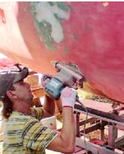
Выравнивание поверхности латки плоскошлифовальной машиной
