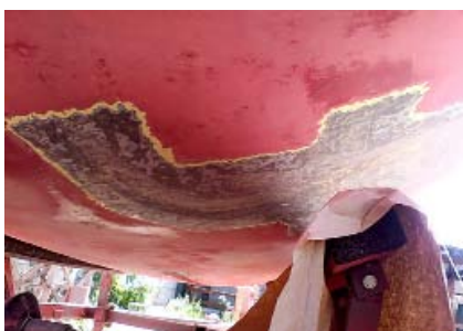
Разделанное углубление для качественной заделки трещины
