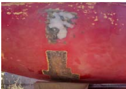
1. Неровные места зашпаклеваны сферой 2. Обнаружена трещина в корпусе, края ее разделаны для заформовки ламинатом
